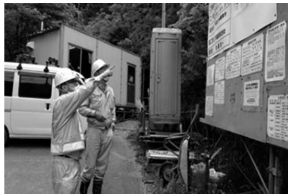
写真-1 検査監による現場点検状況
