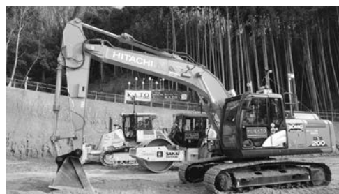
写真－2 遠隔 ICT 建機
