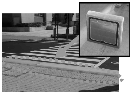
写真 2 IC タグを内蔵した視覚障害者誘導用ブロック
