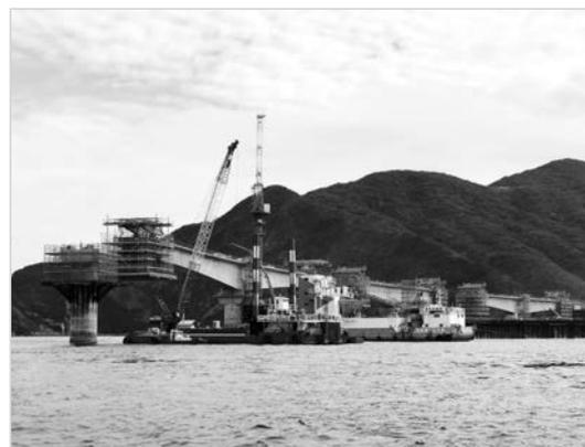
写真－6 上部工打設状況（海上施工）
