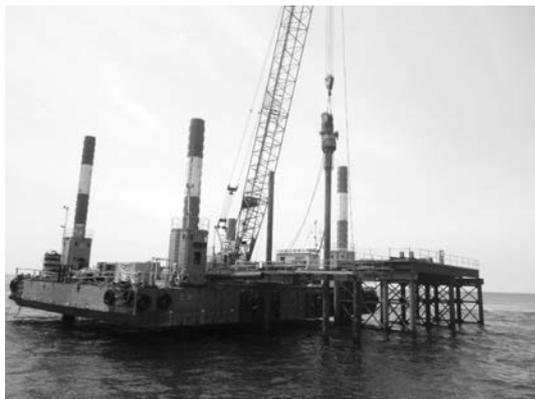
写真－3 SEP船と100t吊りクローラークレーンによる杭建て込み
