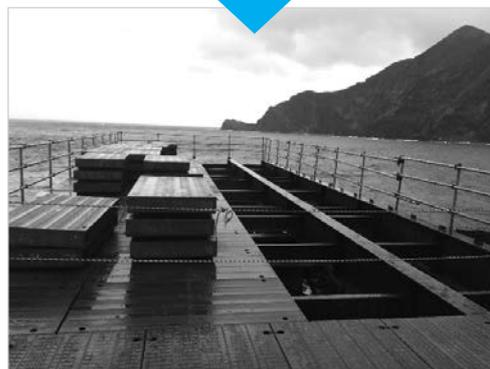
写真－4 仮栈橋の台風対策
