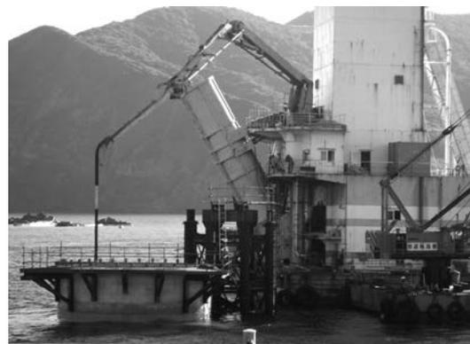
写真－5 コンクリートミキサー船による打設状況（下部工・中詰めコンクリート打設）
