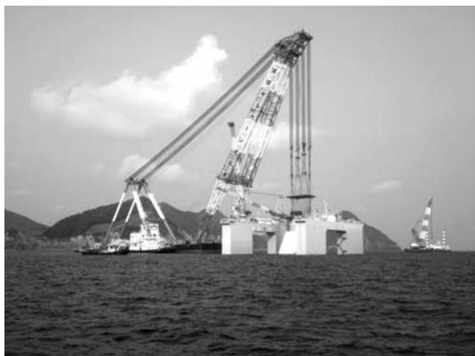
写真-1 大型サルベージ船のケーソン基礎据付
