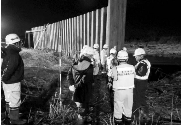
写真-5 堤防破堤箇所での復旧支援
