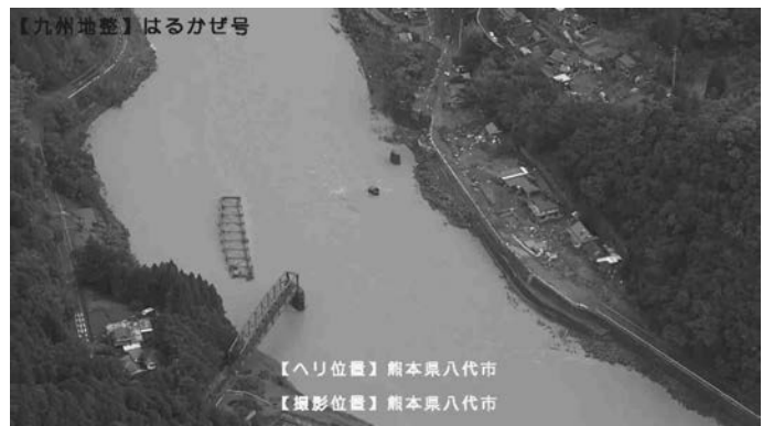
写真－6 洪水流により流失した橋梁
