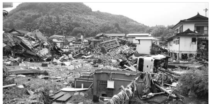
写真－5 球磨村渡地区の家屋倒壊状況 （球磨川右岸：河川より約50mの距離）
