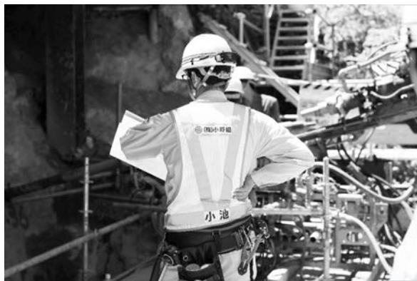
写真-3 うだるような暑さの中、現場で働く人の熱量が伝わってくる（写真：山崎エリナ）
