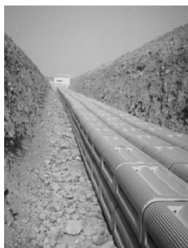
中部国際空港株式会社 空港島滑走路横断および周辺管路
