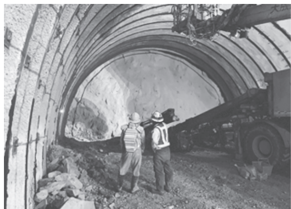
写真－3 投影された地盤の硬軟コンター図 ※実際は、地盤の左側が寒色系（硬い）、右側が暖色系（軟らかい）に色分けされています
