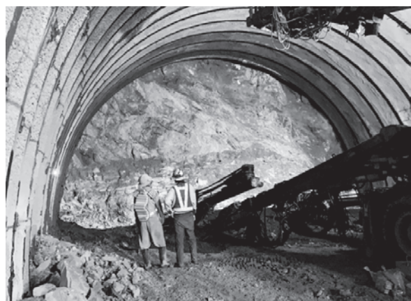
写真－2 投影された掘削面の写真
