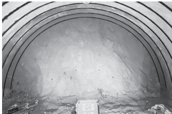
写真－1 吹付けコンクリートに覆われた切羽
