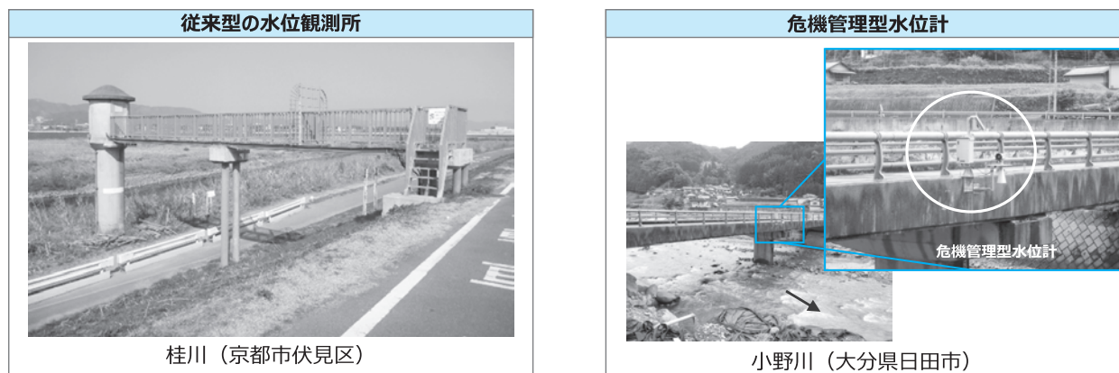
図－1 水位観測所（左）と危機管理型水位計（右）
