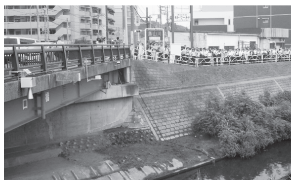
写真－1 鶴見川水系鳥山川での現場実証
