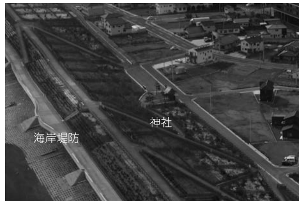
写真－2 防災緑地と神社（いわき市久之浜）
