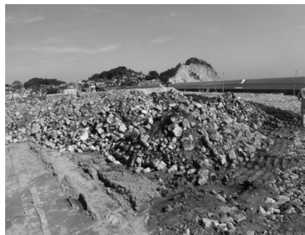
写真－4 盛土材に流用したコンクリートがら（いわき市久之浜）
