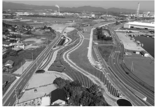
写真－5 原釜尾浜防災緑地（相馬市）完成写真
