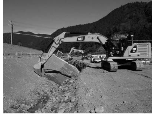
ICT 建設機械による施工
