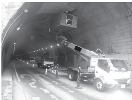
写真－３ 作業状況（全景）
