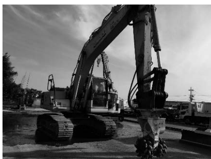
写真－13 チッピング施工機械
