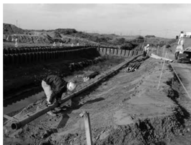
写真-5 ヘッダーパイプ設置状況
