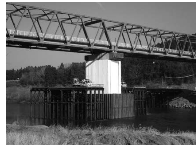
写真－１０ 仮橋設置完了
