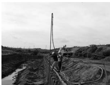
写真-6 ウェルポイント設置状況
