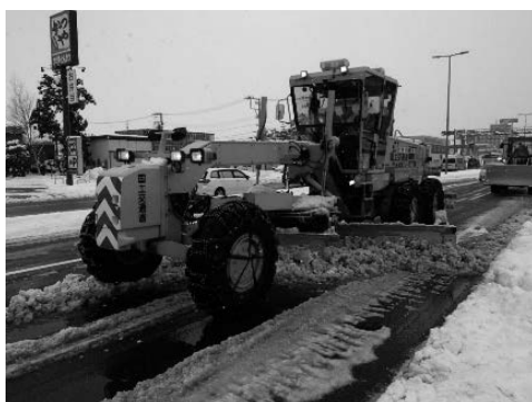
写真－21 除雪状況（路面整正）
