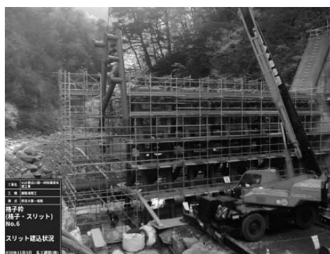
写真－15 鋼管フレーム型砂防堰堤の据付状況
