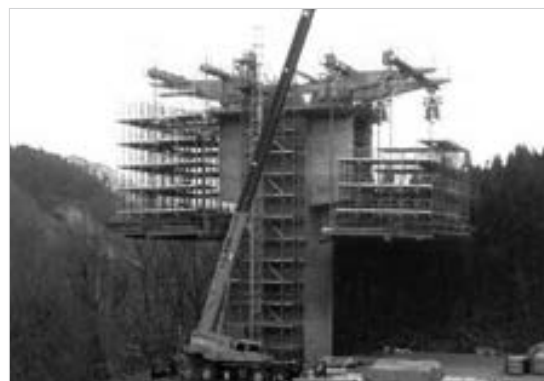
写真－35 張出し施工状況
