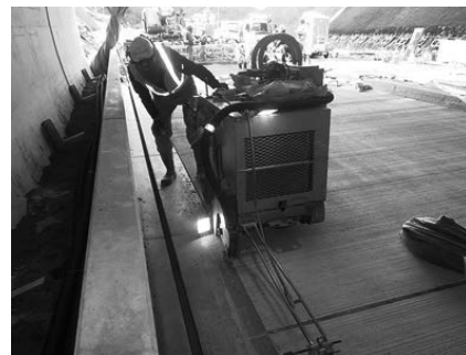
写真－１８ 目地切りの施工状況
