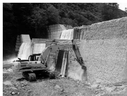
写真－14 チッピング施工状況
