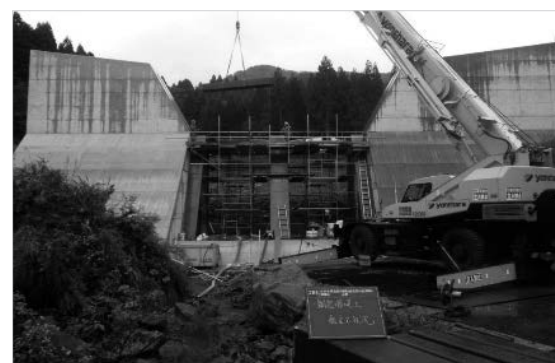
写真－16 バットレス型砂防堰堤の据付状況
