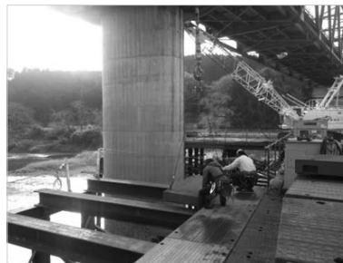
写真－９ 覆工板設置作業
