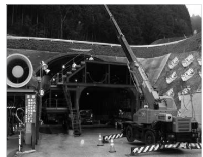
写真-26 防水工台車の組立状況
