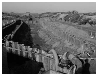
写真-7 設置完了
