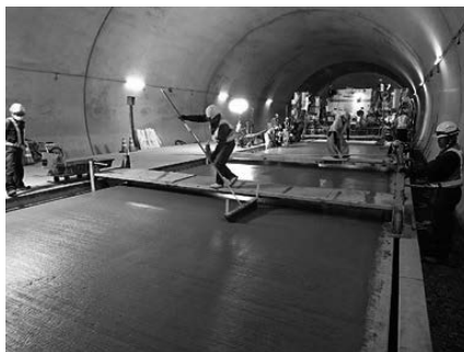
写真－１７ 舗設状況
