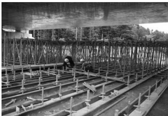
写真－36 くさび結合支保工設置状況
