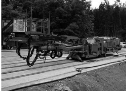
写真-27 レール方式(ドリルジャンボ全景) ※今回廃止
