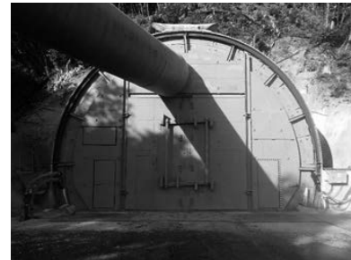
写真－33 防音扉の設置完了
