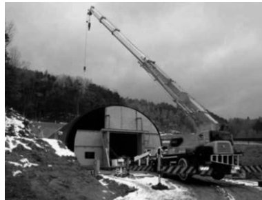
写真－32 防音扉の設置状況②
