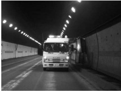
写真－19 壁面清掃状況①
