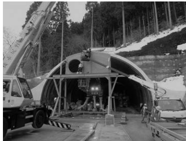
写真－31 防音扉の設置状況①
