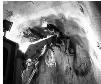
写真-30 タイヤ方式(ドリルジャンボ施工状況)
