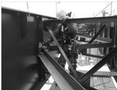
写真－８ 上部工設置作業
