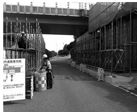
写真－37 支柱支保工設置状況
