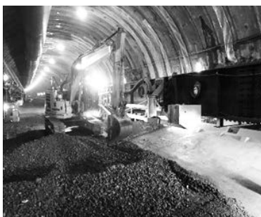
写真-24 インバート埋戻し施工状況 （左：バックホウ、右：振動ローラ）
