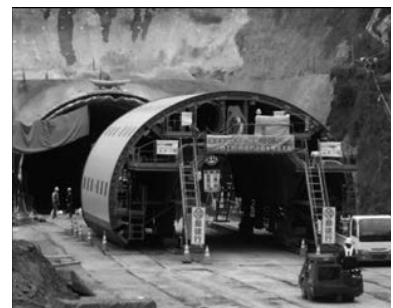
写真-25 スライドセントルの組立状況
