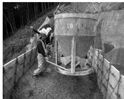
写真－12 砂防堰堤コンクリート打設
