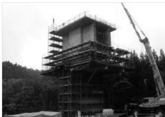
写真－34 柱頭部施工状況
