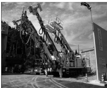
写真-23 コンクリート吹付機（エレクトラ装置付）による鋼製支保の建込状況
