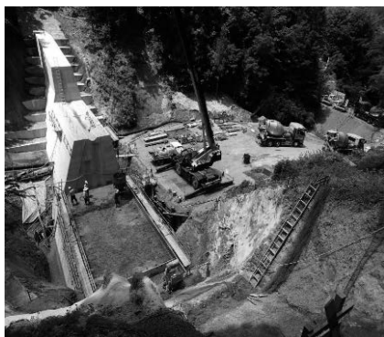
写真－11 砂防堰堤コンクリート打設（全景）
