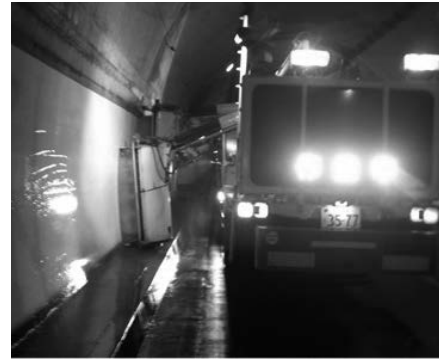
写真－20 壁面清掃状況②
