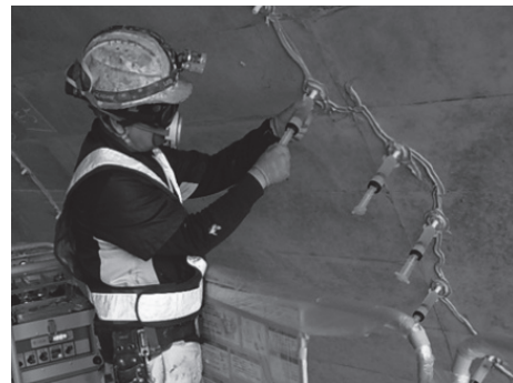
写真－２ 補修材の注入状況
