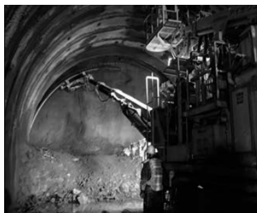
写真-23 コンクリート吹付機（エレクトラ装置付）による鋼製支保の建込状況
