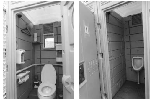
写真-1 設置の工夫例① 上：全景，下：大・小便器
