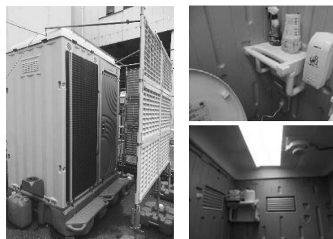
写真-2 設置工夫例② 左：全景，右2点：小物置き場
