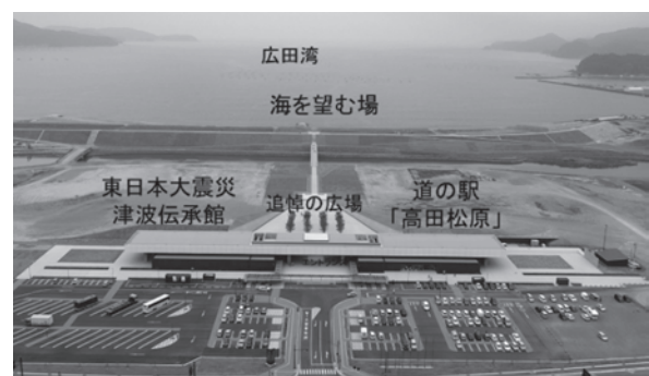
写真－4 高田松原津波復興祈念公園(陸前高田市)
