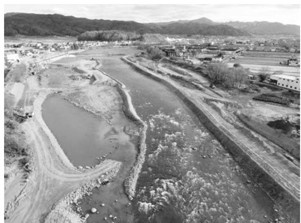
写真－4 佐久市原地先（千曲川右岸）の堤体盛土完了状況（清水建設提供）
