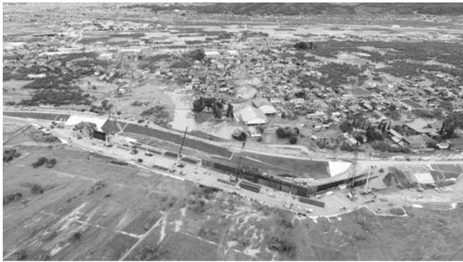
写真－1 建設が進む鋼矢板仮締切堤防（長野市穂保地区）
