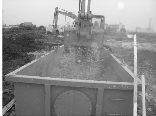
写真 3 故紙のバックホウ攪拌状況
