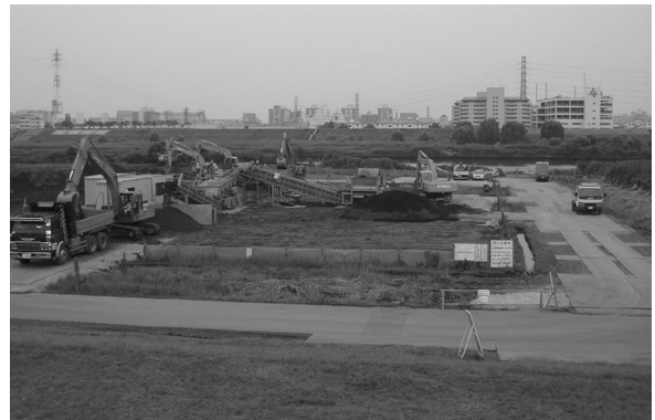
写真 1 浚渫土改良ヤードにおける施工状況
