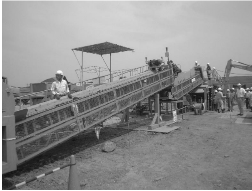
写真 2 万能土質改良機による混合状況
