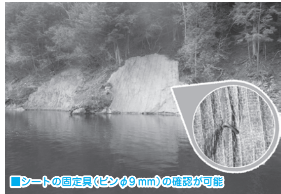
図-7 植生シートの施工状況確認
