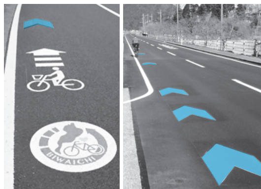
写真-8 青矢羽根本設置
