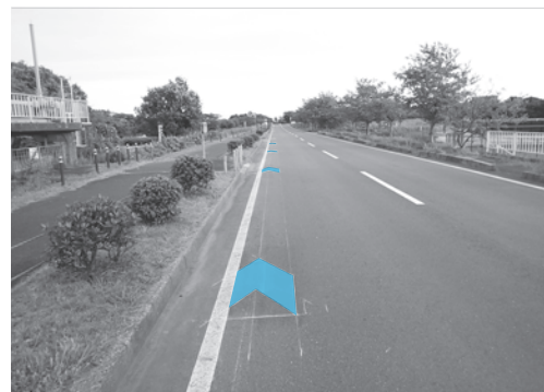
写真ー7 青矢羽根の試験施工
