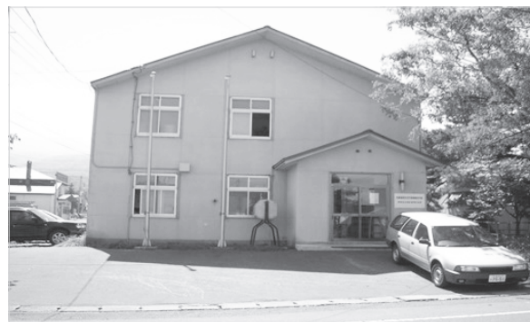
写真－1 道管理施設を役場施設へ移転統合
