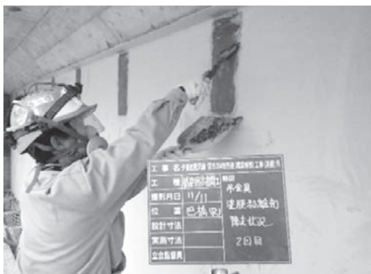
写真-2 橋梁修繕工事（塗膜除去）における 新技術の採用
