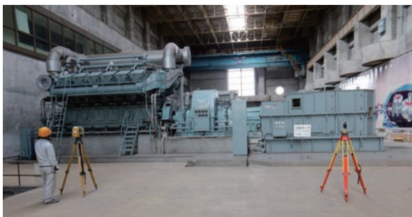
写真-4 地上レーザ観測
