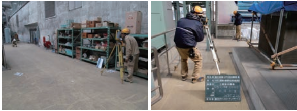
写真-2 標定点測量
