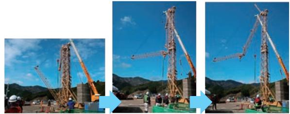
写真-4 定置式水平ジブの立ち上げ状況
