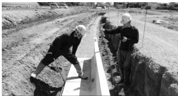
写真－7 L型擁壁施工状況
