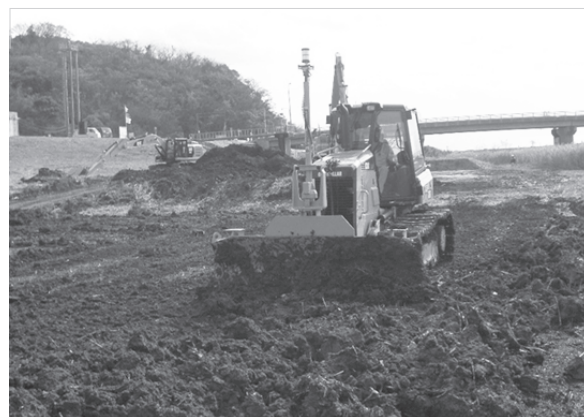
写真－1 情報化施工実施状況（ブルドーザー）
