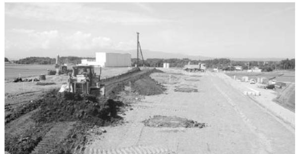
写真-2 設置した層厚の目安で敷き均すブルドーザ
