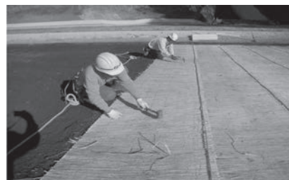
目串しの打込作業
