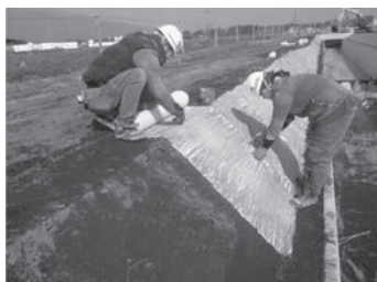
人工芝の設置作業
