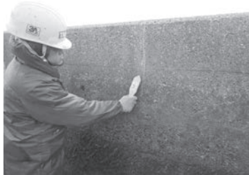
開水路の研磨作業(1)
