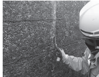
開水路の研磨作業(2)
