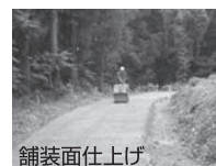
舗装面仕上げ
