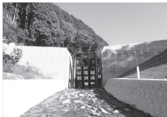
写真－6 透過型砂防堰堤の整備
