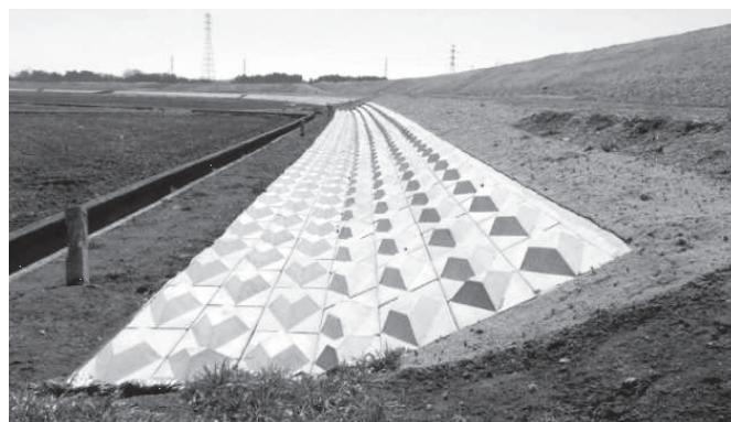
写真－5 河川堤防の法尻補強
