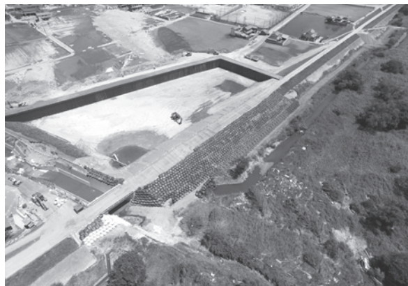
写真－3 小田川の応急復旧完了
