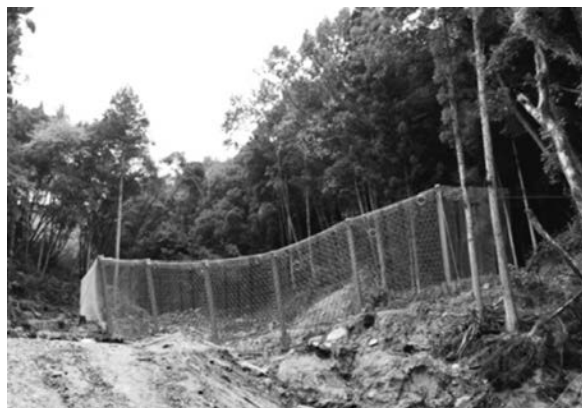
写真－5 広島県安佐北区の「強靱ワイヤーネット工」
