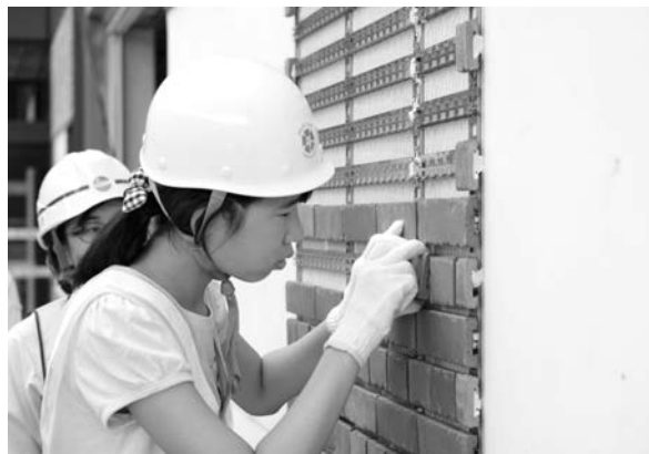
写真-7 お仕事体験 タイル張り
