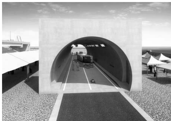
図-4 試験用トンネル
