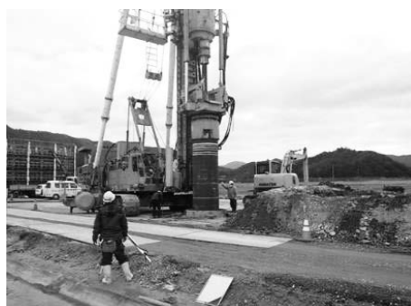
写真-8 鋼管定着状況
