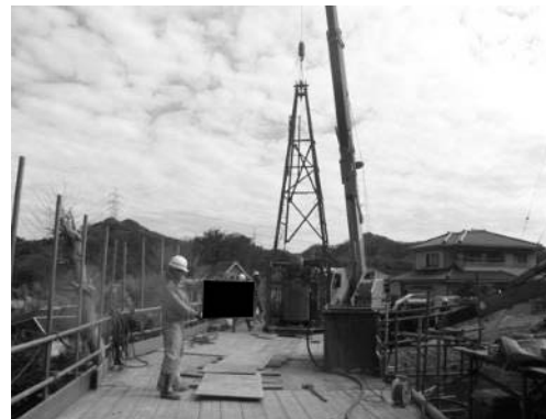
写真-9 やぐら設置状況
