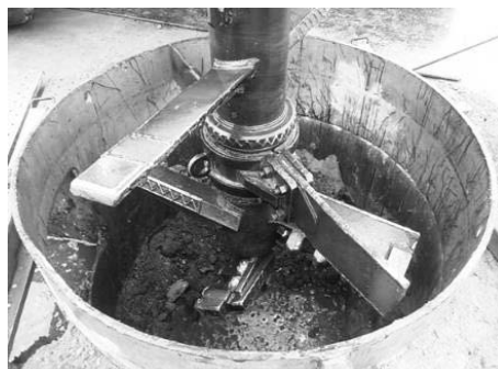
写真-5 口元管設置状況
