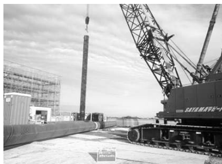
写真-6 鋼管吊込み状況
