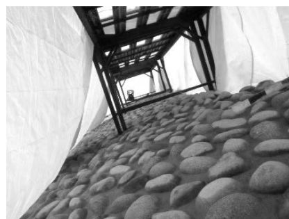
写真-4 仮囲い内の状況
