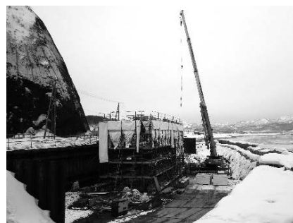
写真-3 雪寒仮囲い設置状況
