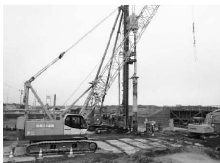
写真-7 鋼管沈設状況
