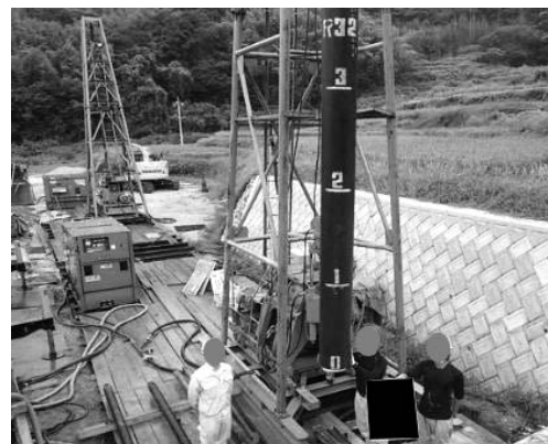
写真-10 鋼材建込み状況
