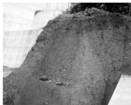
写真-2 法面清掃完了後状況
