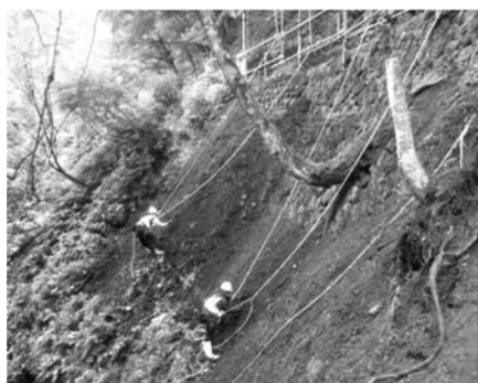
写真-1 法面清掃状況
