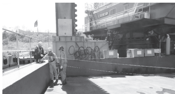
写真－5 積載部測量状況
