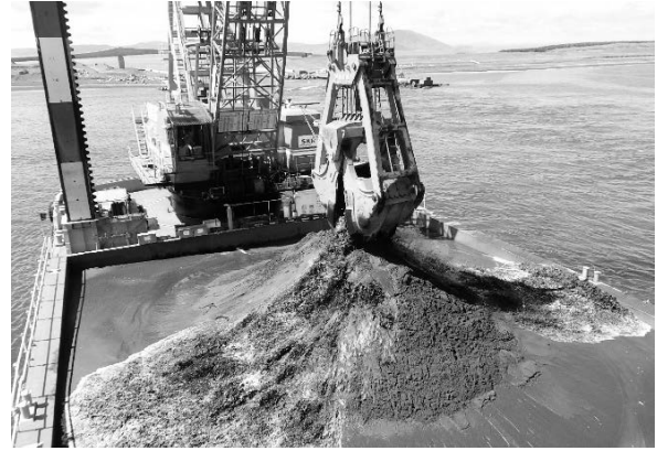
写真－ 11 浚渫土砂積込状況
