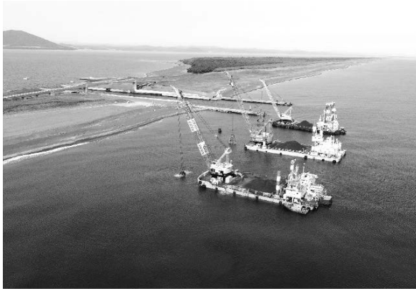
写真－ 9 サンドポケット浚渫状況①
