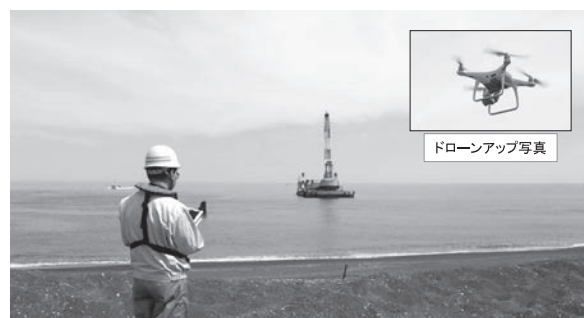
写真－7 ドローン操作状況
