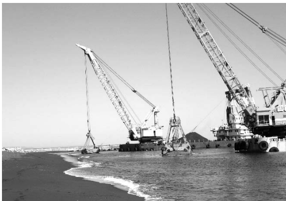
写真－ 10 サンドポケット浚渫状況②
