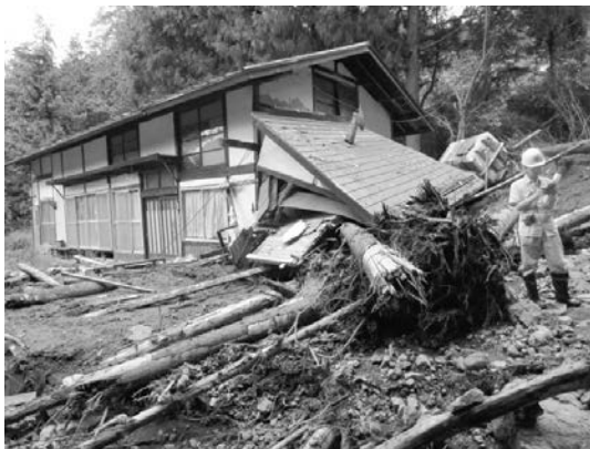
写真－7 家屋の一部損壊状況
