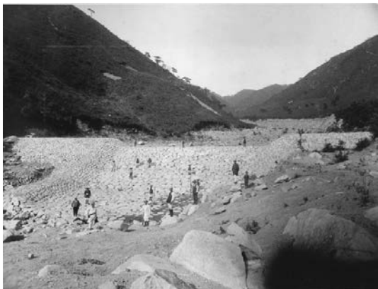
写真-1 第7号堰堤竣工写真（明治43年）
