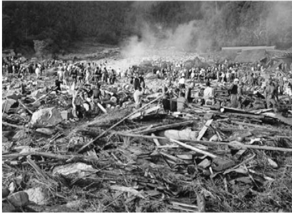
写真-3 根場地区の被災状況
