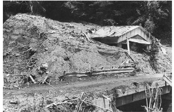
写真-5 早川町雨畑地区の被災状況
