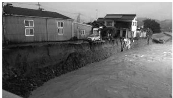
写真－10 河岸洗掘被害が発生（筑後川水系花月川）
