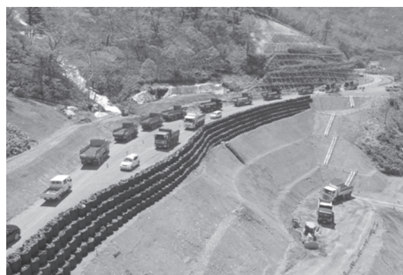
写真－4 工事用道路の工事車両走行状況 （日勝峠帯広側 7 合目 大規模盛土崩壊箇所）
