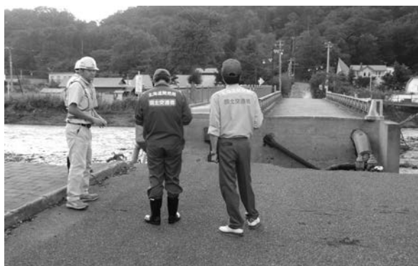
写真－3 橋台背面の洗掘により被災した神社橋(新得町)の被害状況調査を行う TEC-FORCE
