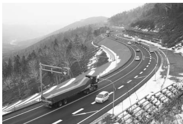
写真－7 通行止め解除後の状況
