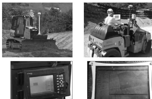
写真－6 ICT 建設機械施工状況
