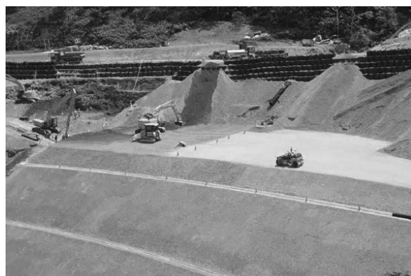
写真－5 ICT 土工施工状況 （日勝峠帯広側 7 合目 大規模盛土崩壊箇所）
