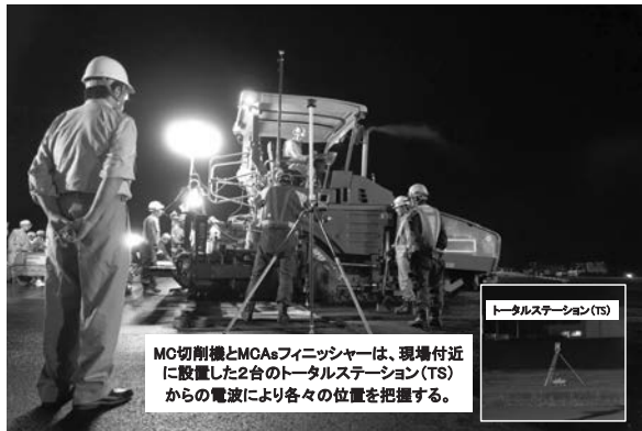
写真－3 青森空港滑走路・誘導路改良工事見学会 (H29.7.14)
