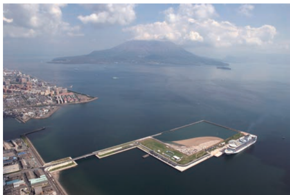
写真-4 1期1工区供用開始 (H19.9)
