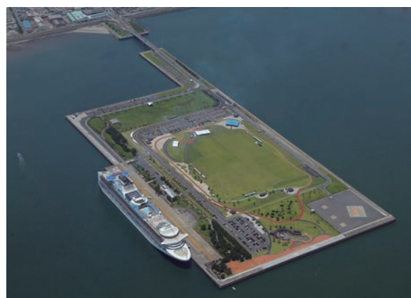
写真-5 1期2工区供用開始 (H28.7)
