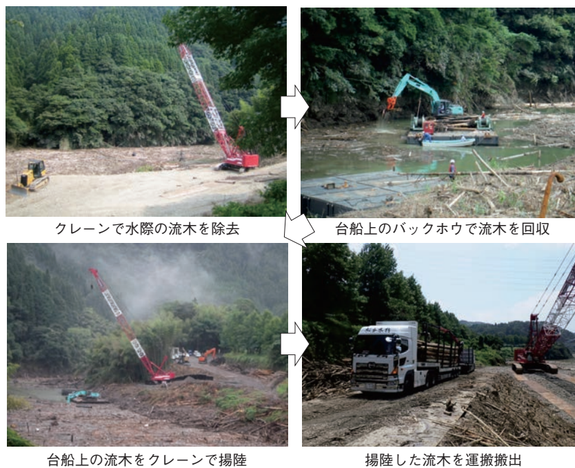
写真-2 寺内ダム貯水池内の流木回収状況 (呑吉地区)
