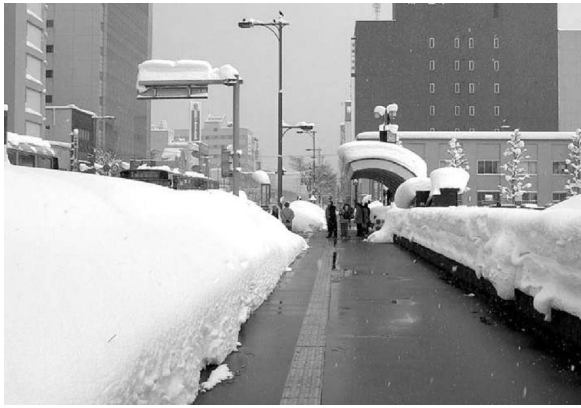
写真 2 融雪施設（地中蓄熱利用方式）設置後の状況
