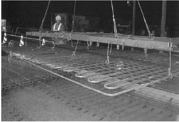
写真 3 放熱管の布設状況
