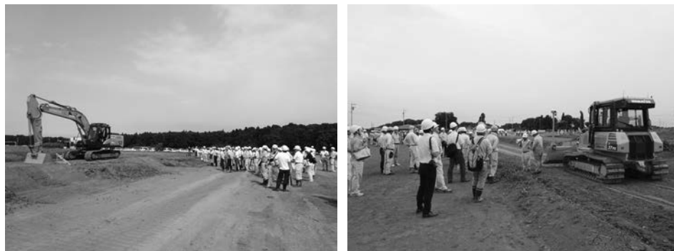
写真-1 現場見学会の実施状況
