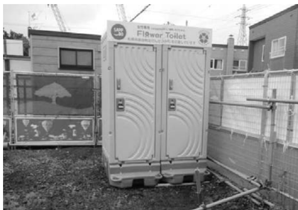
写真-1 女性用トイレ・更衣室の設置に対する助成
