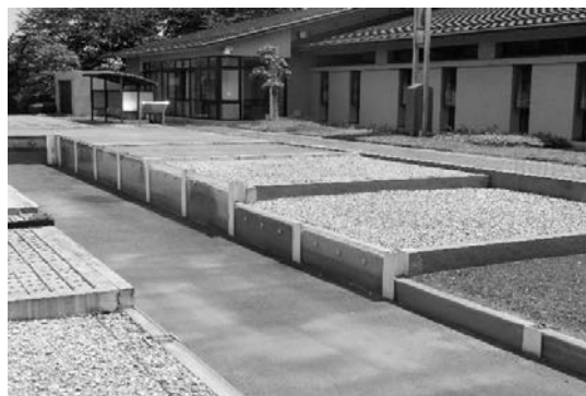
写真－3 舗装モデル
