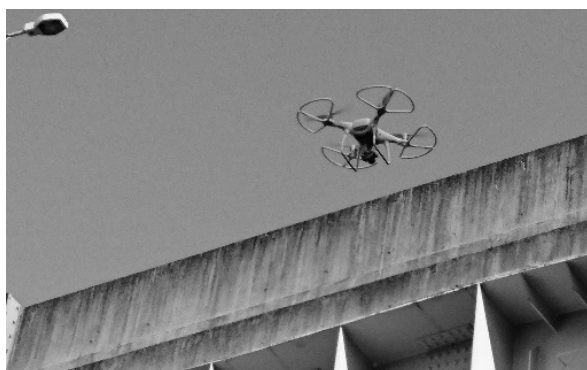
ドローンによる橋梁点検
