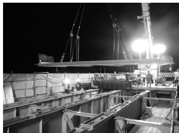
写真－１ 床版取替工事の実施状況
