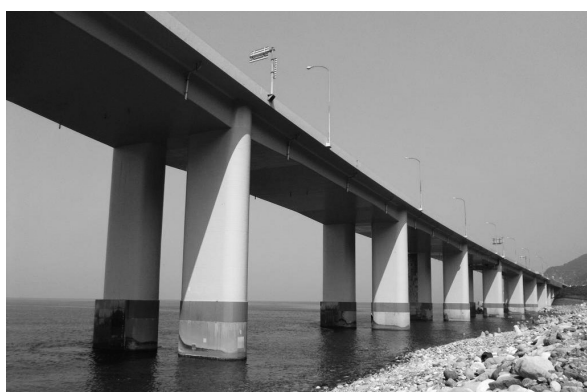
写真－３ 耐震補強対象となる海上部の高架橋
