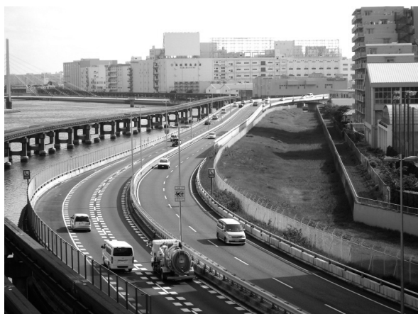
写真－1 着工前状況（鮫洲埋立部）
