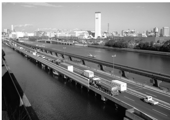
写真－2 着工前状況（東品川栈橋部）
