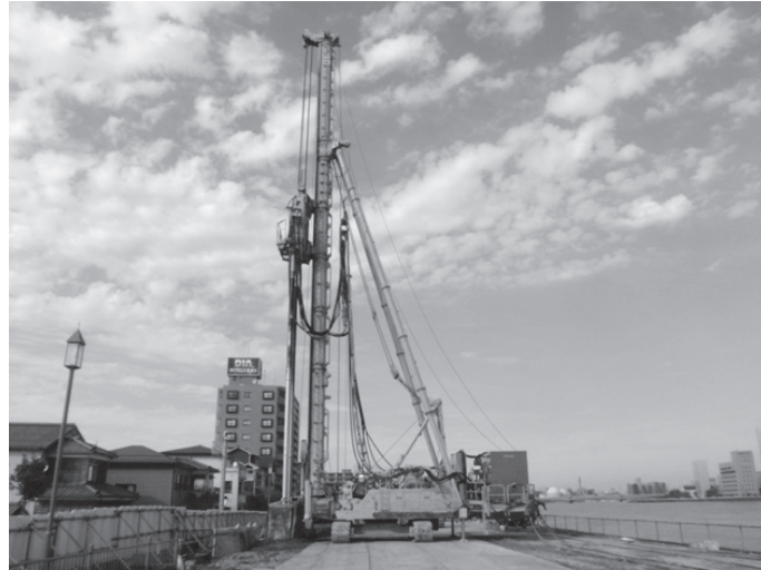
写真-1 深層混合処理機
