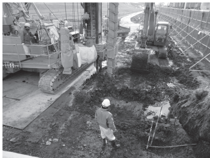
写真-3 杭打設状況
