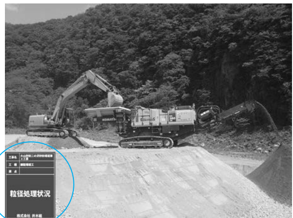
写真-14 電子小黑板を活用した工事写真
