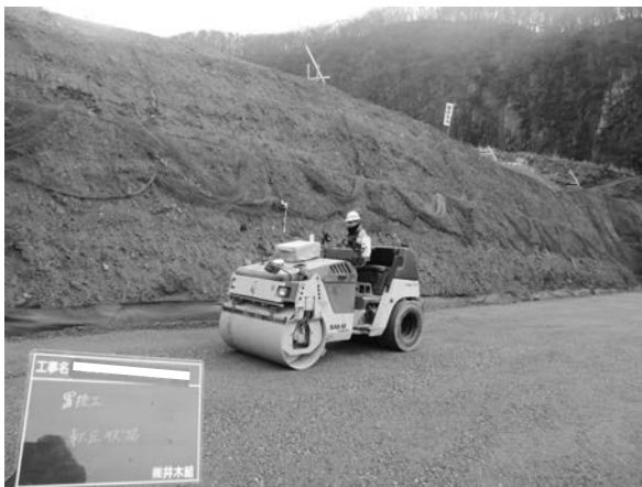
写真-12 施工状況
