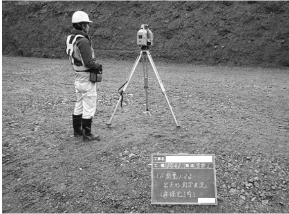
写真－5 LSを用いた出来形計測状況
