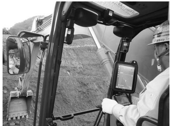
写真－9 MCを用いた掘削作業状況
