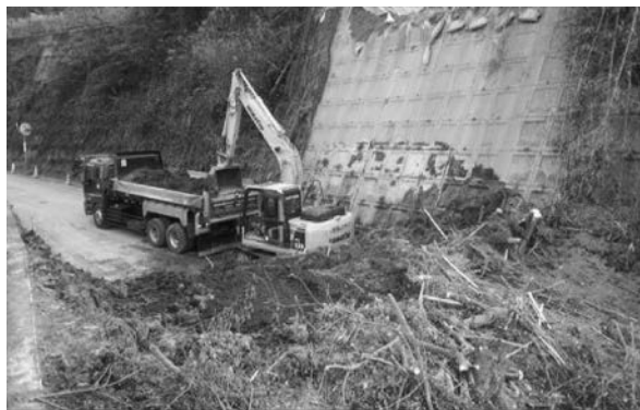
写真－1 熊本地震 道路啓開・復旧作業
