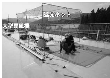
▲遮光材入りのメッシュシートによる日除け設備と大型扇風機の設置
