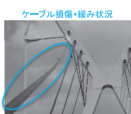
ケーブル損傷・繰り込み状況
