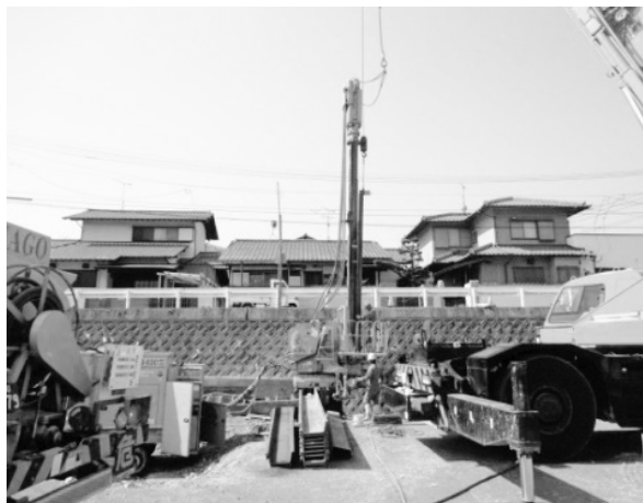
写真－10 鋼矢板施工状況
