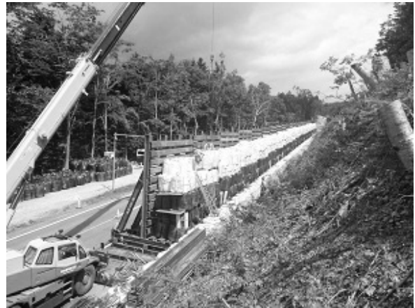
写真-8 大型土のう設置状況
