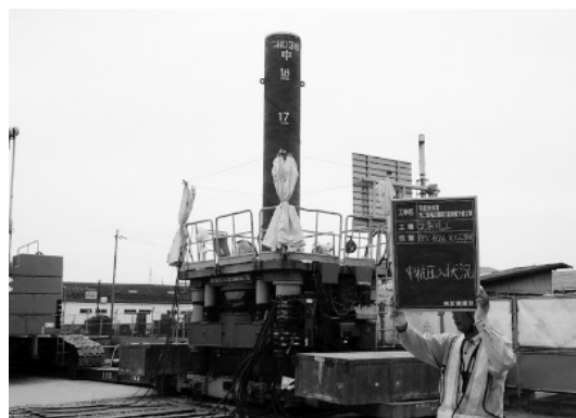
写真－1 回転圧入状況
