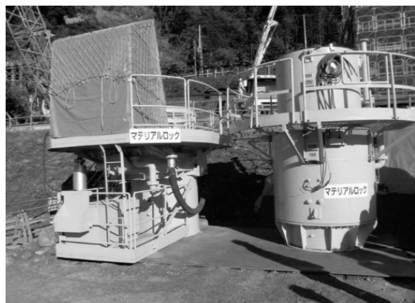
写真－３ ニューマチックケーソン工のマテリアルロック
