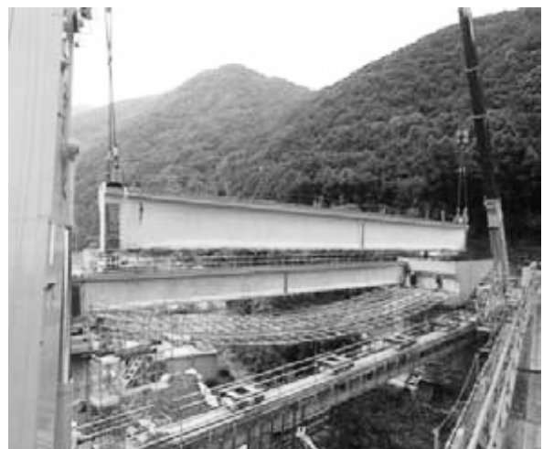
写真-9 主桁架設状況
