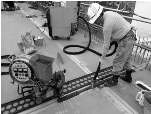
写真-6 溶接施工状況
