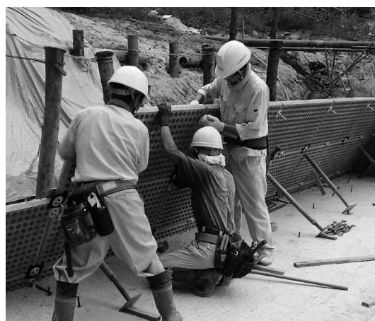
写真－４ 残存型枠組立・設置状況
