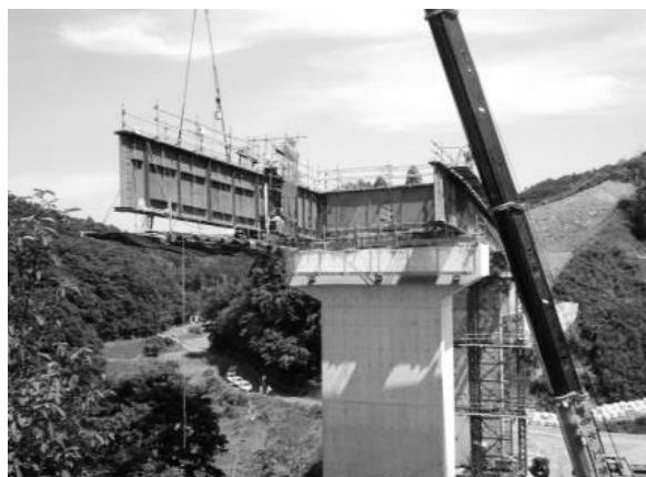
写真－５ 少数I桁架設状況
