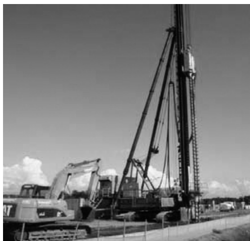
写真－２ 杭打設状況
